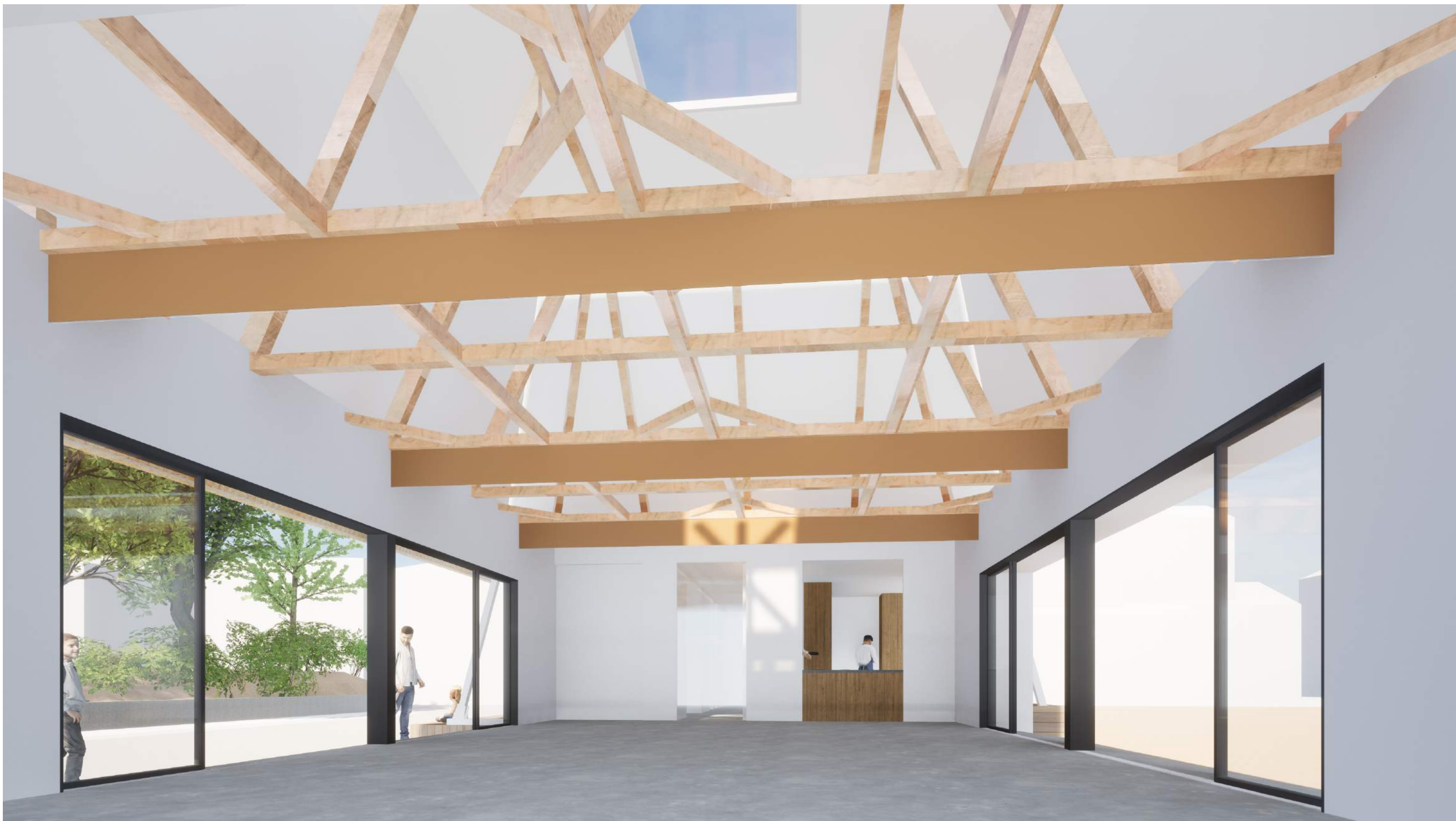
天井が高く、明るく開放的な集会室。既存木造架構だけでなく、耐震改修の鉄骨梁も見え、これまでの歴史も感じることでできる空間となります。
